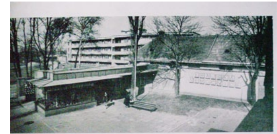
KRAJSKÁ NEMOCNICE V OSTRAVĚ-ZÁBŘEHU 1912-1972
